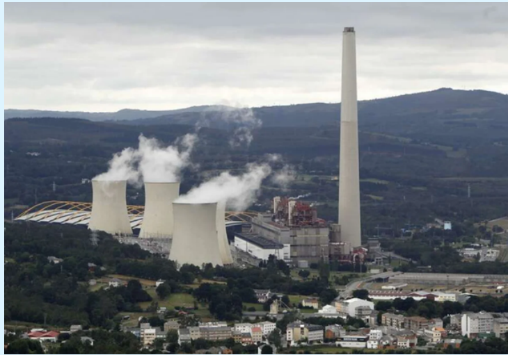
Central térmica de As Pontes. Fuente: abc.es
