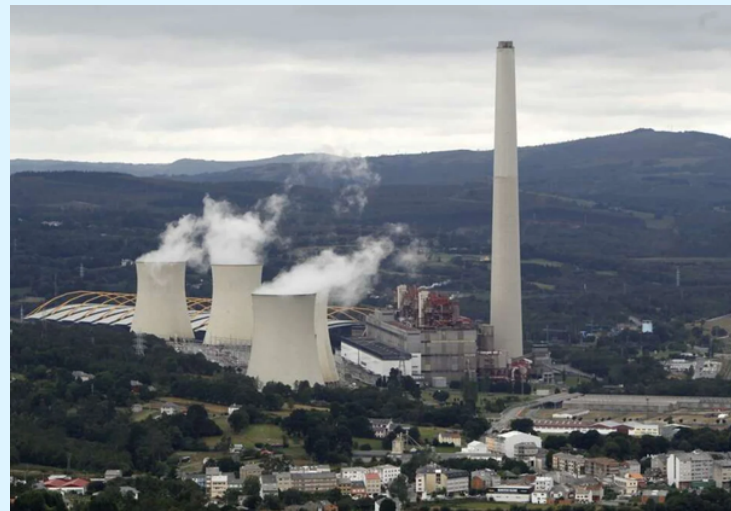
Central térmica de As Pontes. Fuente: abc.es
