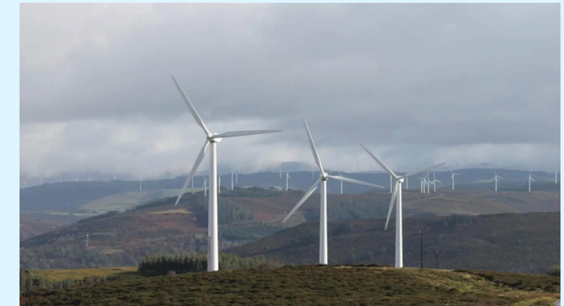
Parque eólico de Muras (Lugo). Fuente: elprogreso.es
