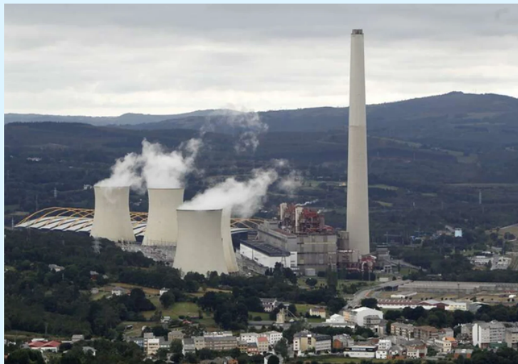
Central térmica de As Pontes. Fuente: abc.es
